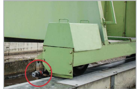
Vorklärbecken: Schmierung der Laufradlager
