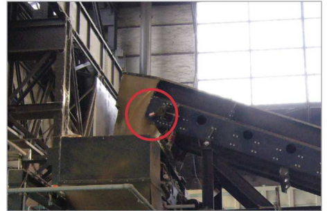
Stehlagerschmierung einer Förderbandanlage
