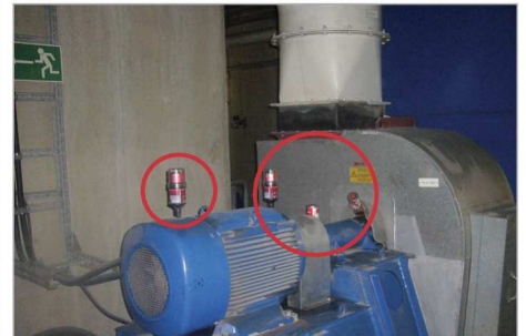
Elektromotoren- und Wellenschmierung eines Sekundärlüfters
