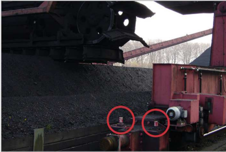
Flanschlagerschmierung der Stützrollen
