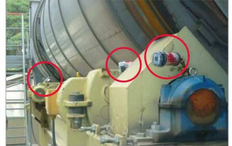
Schmierung der Stehlager an der Trockentrommel
