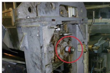
Wellenlagerung an der Förderbandtrommel
