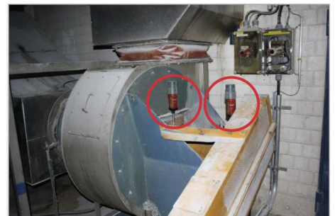
Schmierung der Stehlager an einer Lüfteranlage
