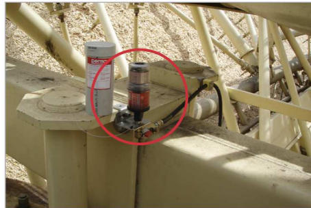
Lagerschmierung der Förderbandanlage
