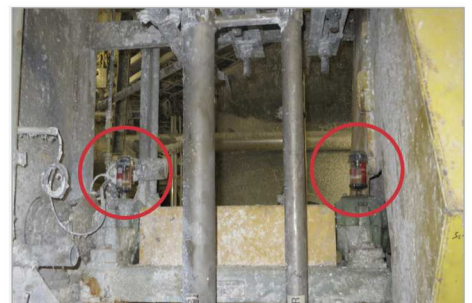
Schmierung der Antriebswelle am Rührwerk
